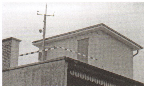
La cabine de l'ascenseur avec le mât météorologique et l'armoire avec les équipements électroniques visible derrière le mât. La photo fut prise lors de l'inauguration en 1995.
